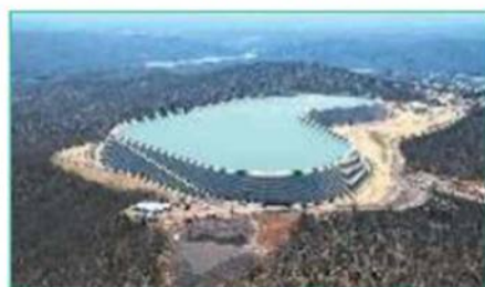
Рис. 10.6. Аккумулятирование потенциальной энергии большими массами поднятой воды: а — накопительный бассейн; б — схема спуска воды к турбине
